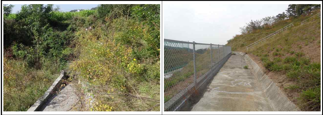
【그림 5.3.3】 배수시설 전경
